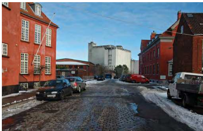
Århusgade med de bevaringsværdige siloer og bebyggelsesmiljøer
