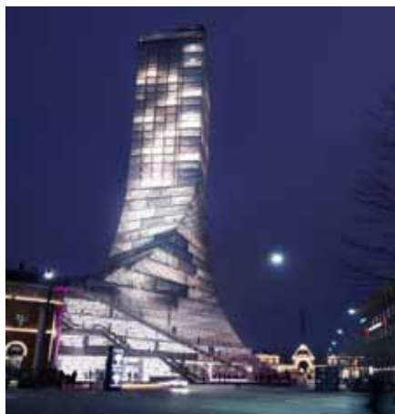
Bjarke Ingels Groups trappeformede og vredne højhus på 130 meter og 30 etager udvider Axeltorv op ad bygningen via en amfie-lignende trappe til højtliggende, offentlige pladser i niveau med byens gamle tagkote. Illustration: BIG-Bjarke Ingels Group
