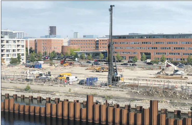
Arbejdet med lejlighederne er i fuld gang på byggepladsen. Om pavillonen kommer op senere, er svært at spå om. Foto: Mikkel Noel Lanzky / Havnefronten.
