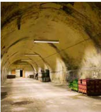
Kælderen under Rød Lagerbygning.
