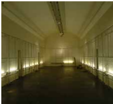
Den eksisterende kælder under pladsen.
