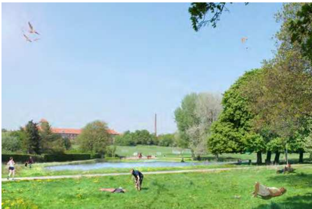
Figur 5-14 Lersøparken – vejvandssø og skybrudsbassin. Vejvandssøen er vist fyldt helt op efter regn. Vandspejlet i søen vil falde til lavere niveau efterhånden som bassinet tømmes til vandtunnelen, indtil niveauet for det permanente vandspejl i søen er nået. Under skybrud vil vandspejlet stå højere end vist og oversvømme et areal omkring vejvandssøen (skybrudsbassinet).
