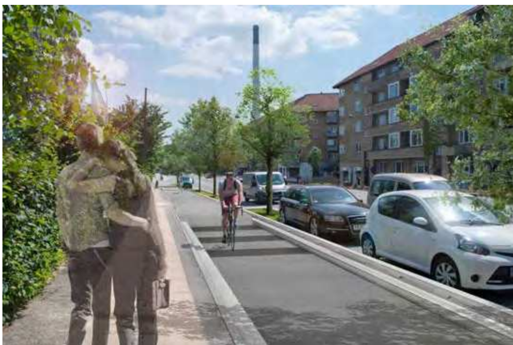
Figur 5-15 Tagensvej – Forsænket cykelsti som skybrudsvandvej. Bag cyklisten er der overkørsel til ejendom. Under overkørslen er der en kanal til vandstrømmen efter skybrudsdykker princippet beskrevet i afsnit 5.9.2. Cyklisten kører over riste, der fører vandet op kanalen på den forsænkede cykelsti. På den anden side af overkørslen er der tilsvarende riste, som fører vandet ned i kanalen.
