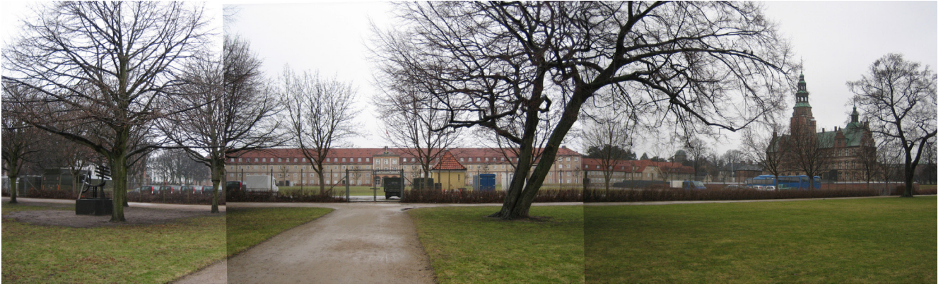
Kig mod nordvest ind på kasernebygningens midterpavillon fra Kongens Have. Den nye øvebygning kommer til at ligge syd for sigtelinjen til venstre i billedet.
