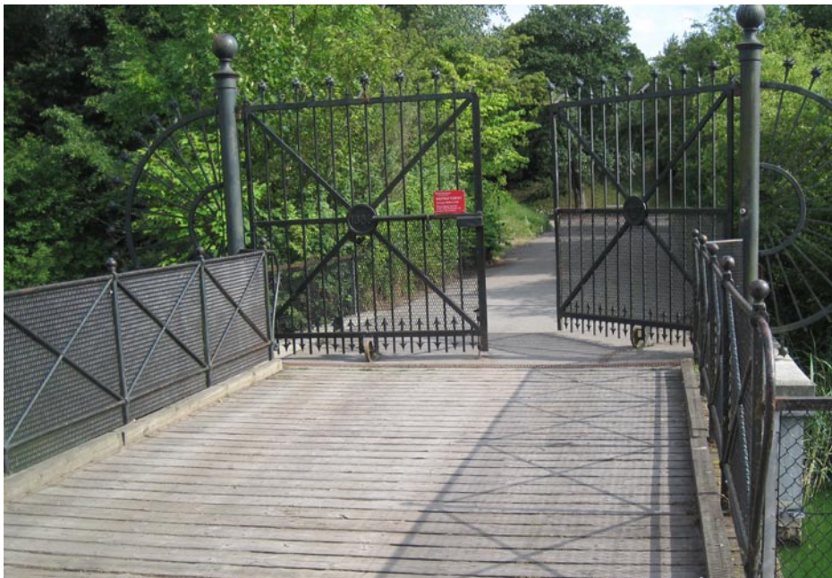
Den oprindelige bro ved den nordlige adgang
