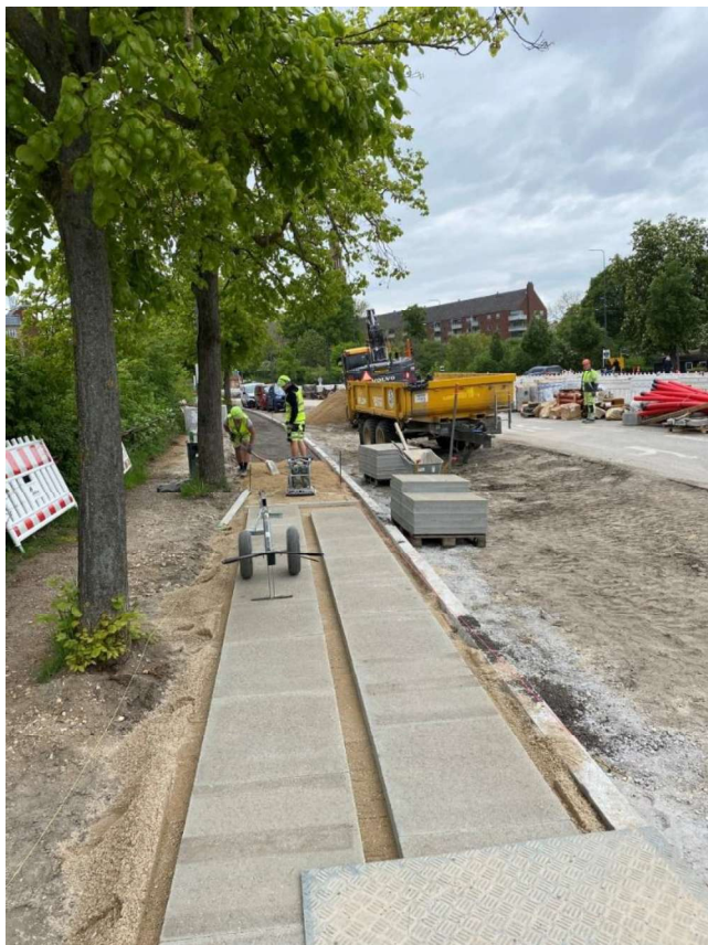
Billede 2. Anlæg af det nye fortov langs Stadsgraven.
