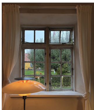
Nye vinduer i Mælkebøtten
