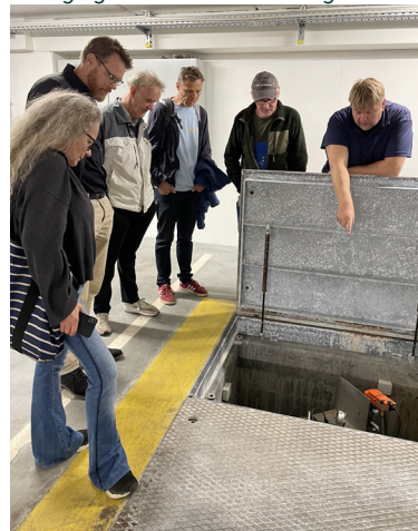
Besigtigelse af ATES-boring
