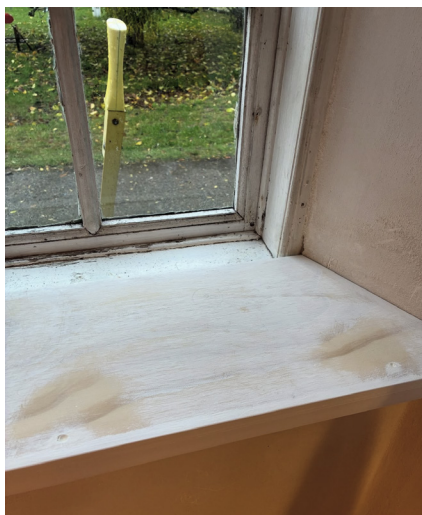
Nye vinduer i Mælkebøtten
