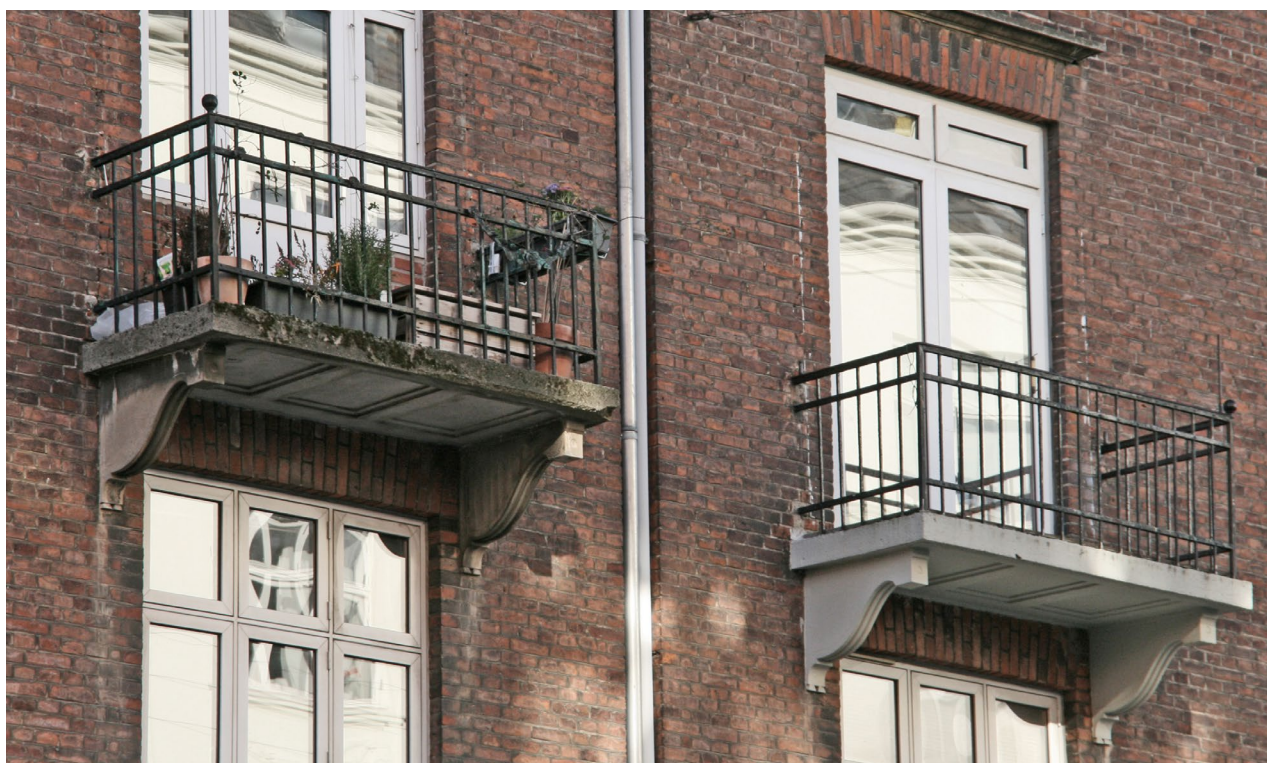
Sommerstedgade. Restaureret oprindelig altan.
