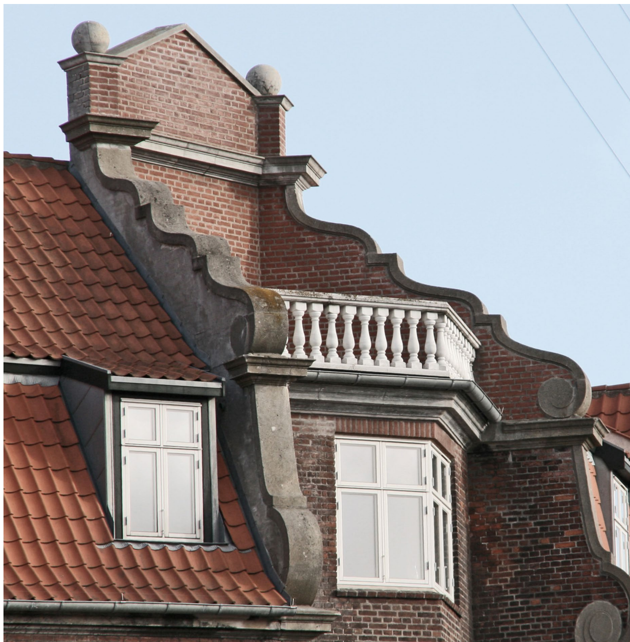
Snorregade. Oprindelig tagterrasse i mansardtag.
