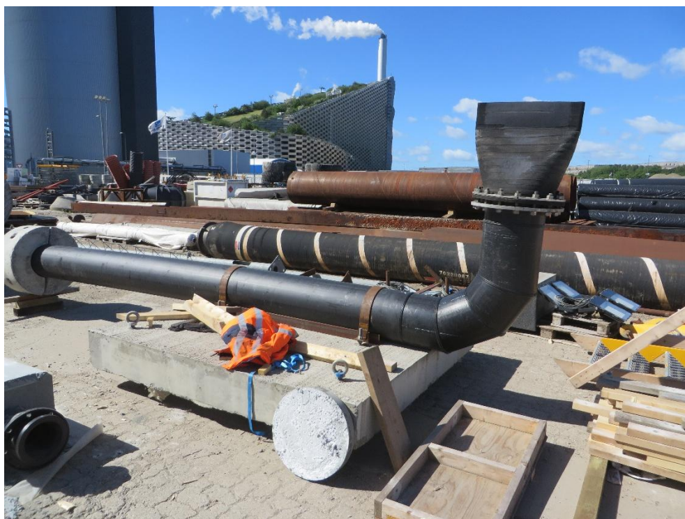
Figur 3. Foto af udløbspunkt inden installation på havbunden.
