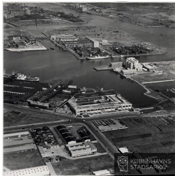
Teglværkshavnen, Ford, Bådehavnsgade Nord 1956
