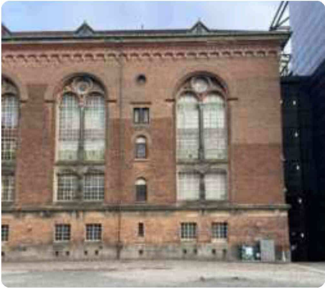
Det Kgl. Bibliotek (Høj bevaringsværdi, niv. 2) - Den nationale institution har eksisteret siden 17-tallet, og råder over den mest komplette samling af bøger trykt på dansk. Denne bygning på Slotsholmen er tegnet af Hans J. Holm indviet i 1906.
