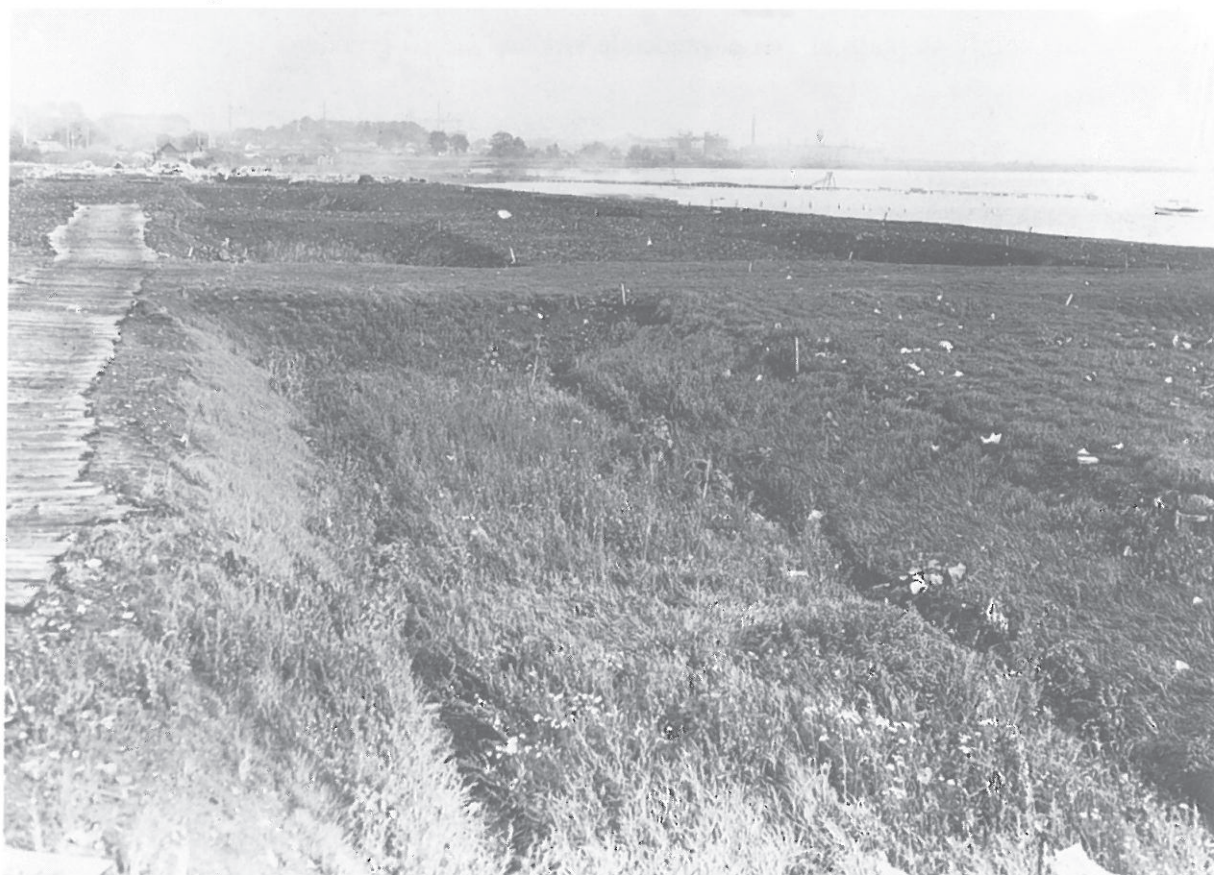
Foreløbigt færdigt parti af lossepladsen med græsbevoksede volde, tværvolde og grave. I baggrunden skimtes konturerne af Sydhavnens industribygninger. Foto Københavns Bymuseum, 1932.
