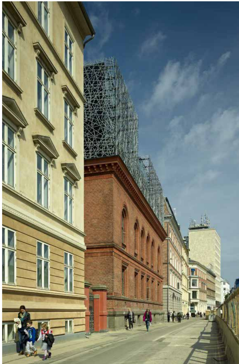
Fritliggende bygning med ny tagetage. Huset er opført med rejst tag, som er fjernet over hovedgesimsen.
