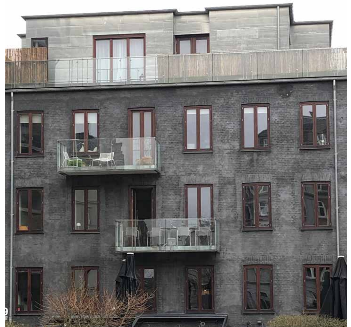
Ny tagetage udformet som penthouse. Huset er oprindeligt opført med rejst tag.
