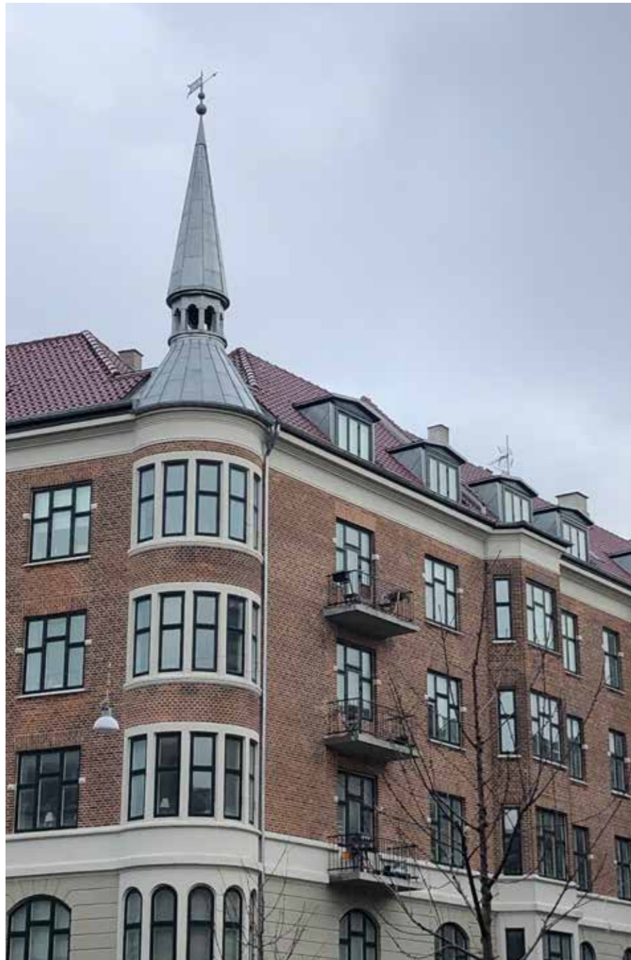
Vellykket tagrenovering på hjørnebygning med tårn.
