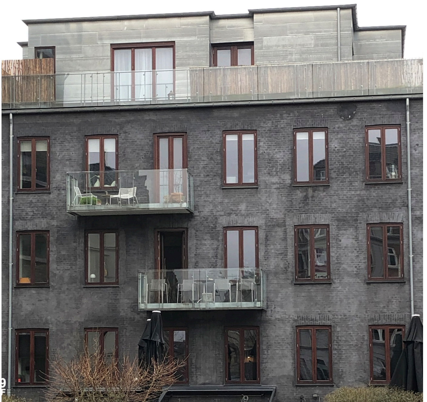
Ny tagetage udformet som penthouse. Huset er oprindeligt opført med rejst tag.
