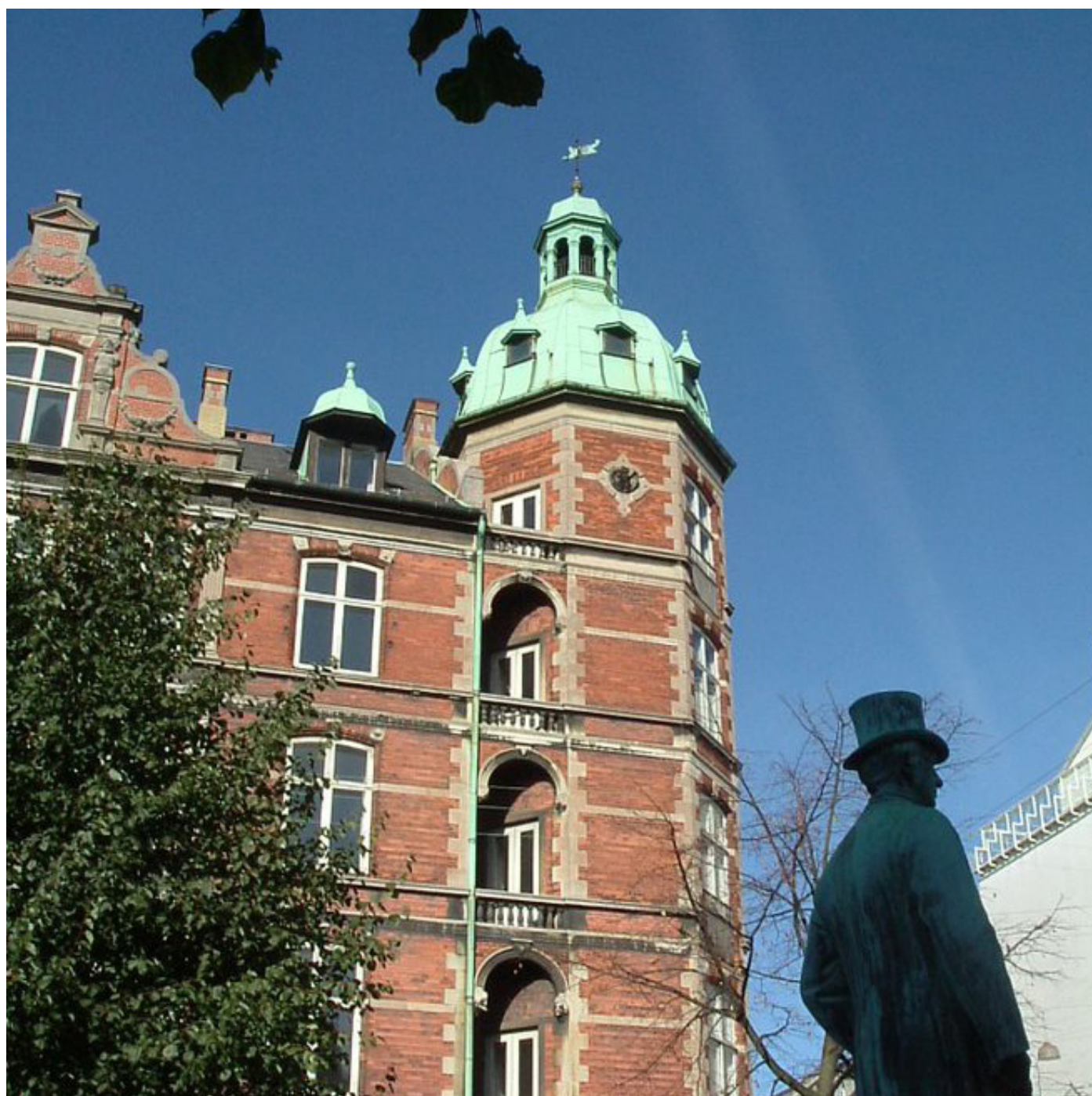
Hjørnebygning med markante og arkitektoniske bygningselementer i taget.
