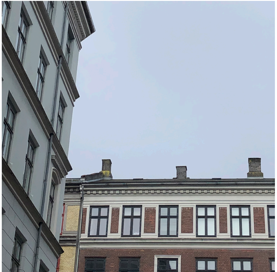
Hovedgesimsen afslutter facaden og danner overgang mellem facade og tag.
