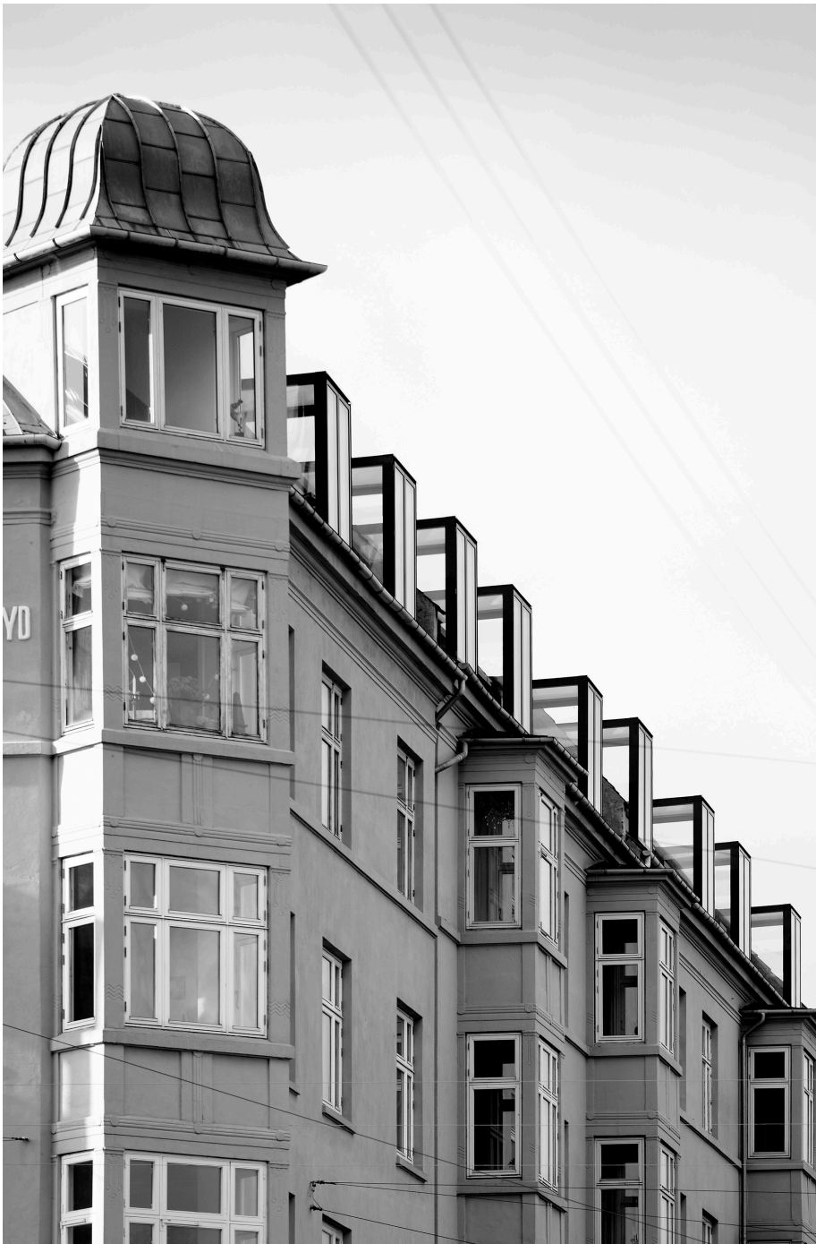
Nye kviste der med sine materialer og udformning er tilføjet som en nyfortolkning af et klassisk bygningselement.
