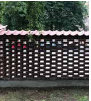
Perforering af muren
