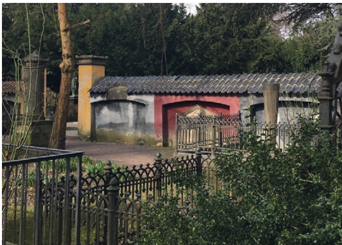
Afdeling A - Indre mur
