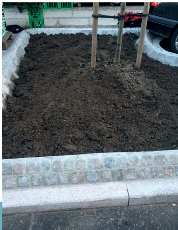
Eksempel på plantehul 10 m 2 med muld, hvor man kan se bagstøbning inden muldulægning.
