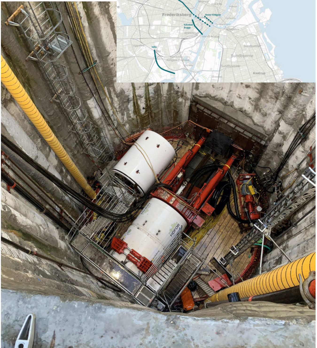
↑ Kalvebod Brygge Skybrudstunnel, foto HOFOR
