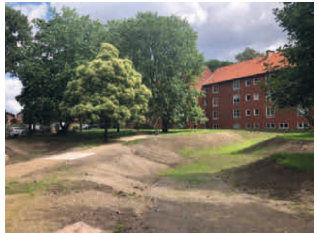
↑ Anlægsarbejder i Husum Vænge
