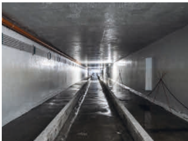
↑ Foto af bassin under Lyngbyvej/Helsingørmotorvejen (foto HOFOR)
