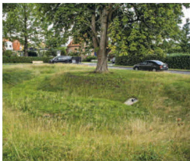
↑ Regnbed samt bassin på C.J. Frandsensvej (foto HOFOR)
