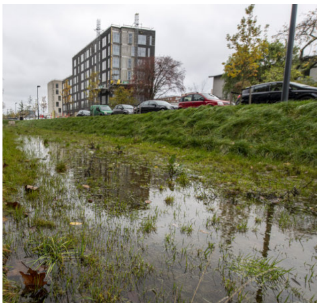
↑ Forsinkelsesbassin langs Ved Amagerbanen (foto Troels Heien, Københavns Kommune)
