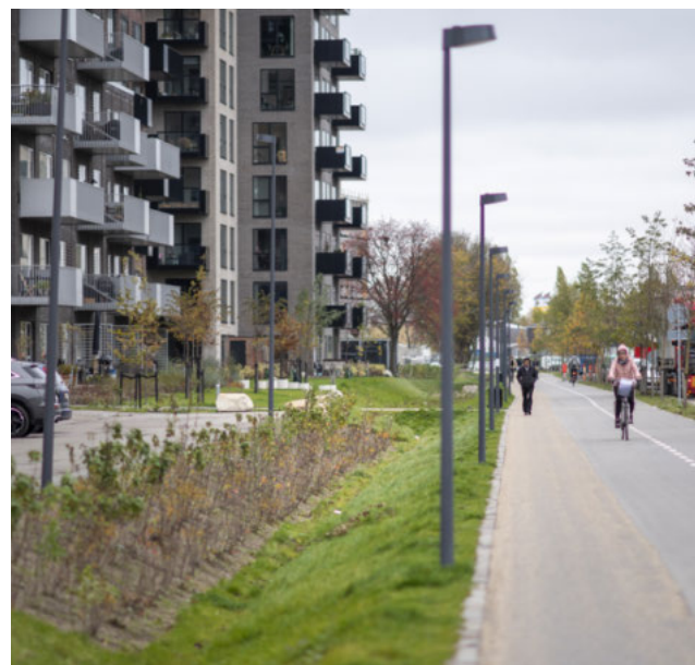
↑ Forsinkelsesbassin langs ved Amagerbanen og cykelsuperstien Københavnerruten (foto Troels Heien, Københavns Kommune)
