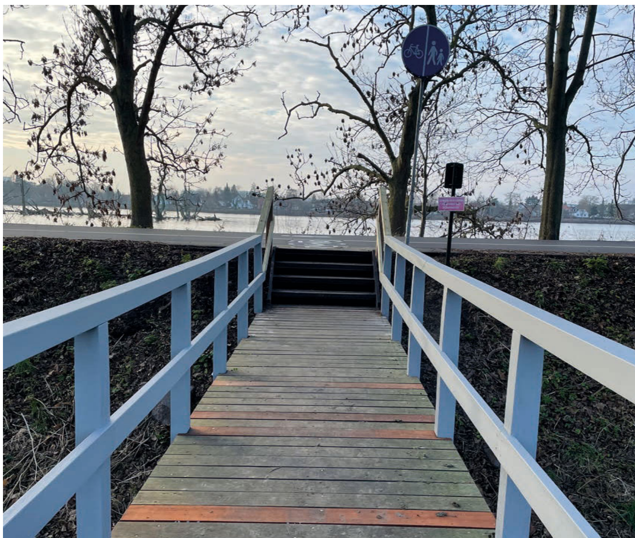
Bro og trappe mellem stien omkring Damhussøen og Ved Damhussøen, ud for Hasselvej
