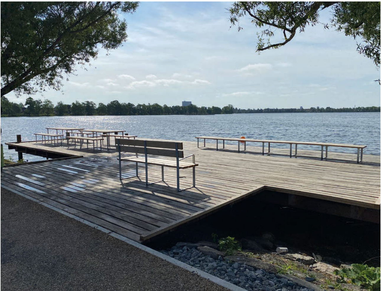
Ny platform med udsigt over Damhussøen
