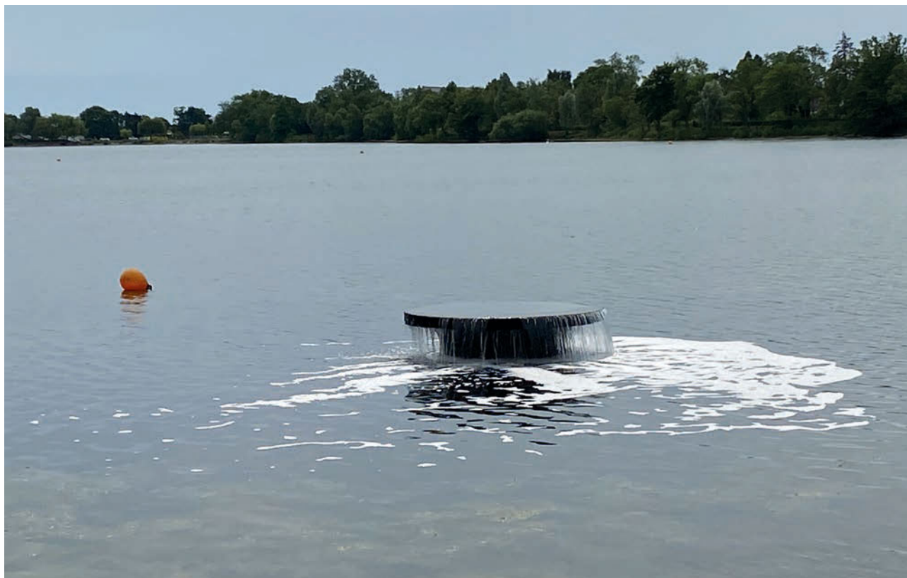
'Vase' hvor igennem der tilføres vand til Damhussøen ved oppumpning fra Harrestrup Å.
