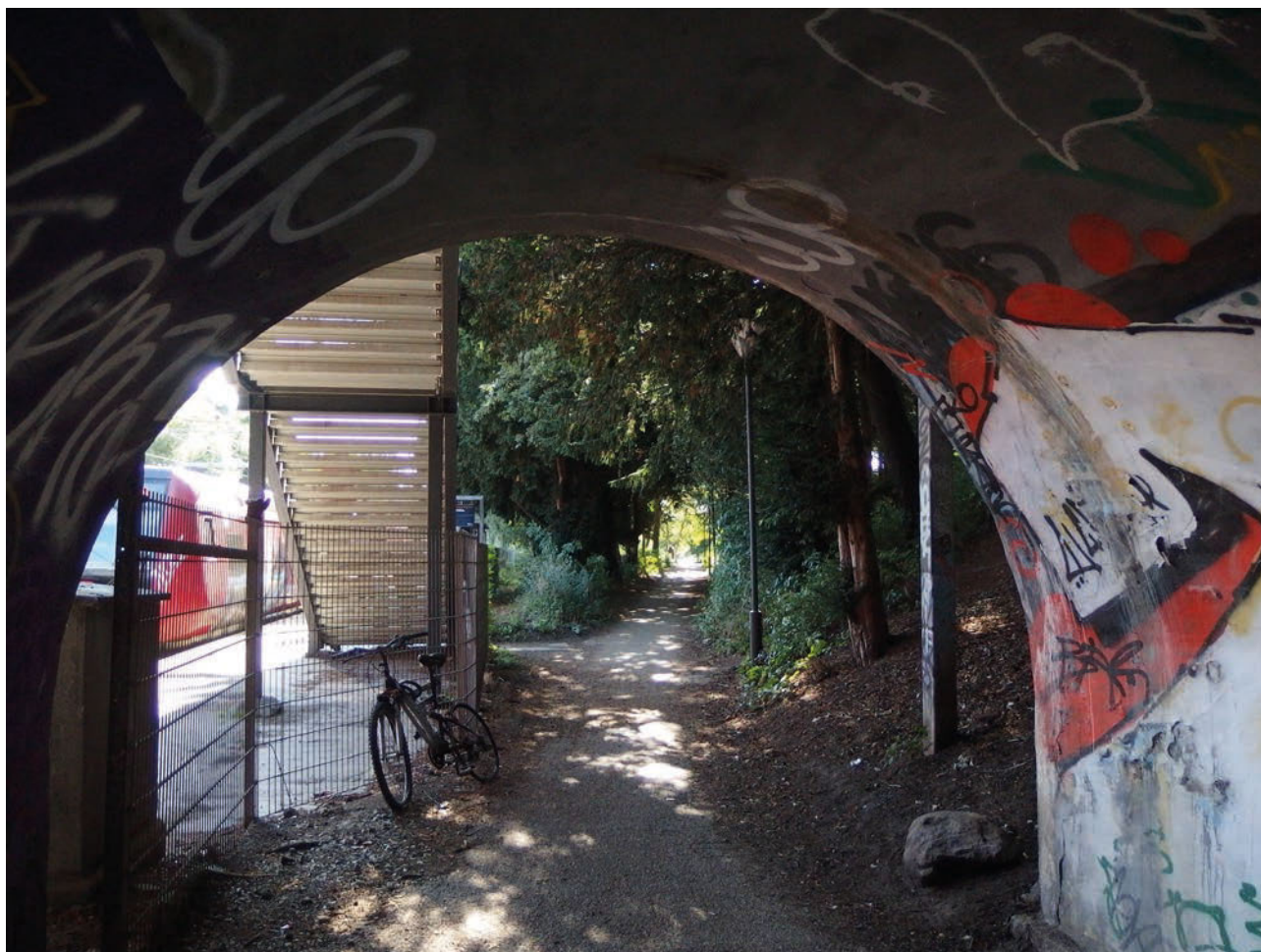
Viadukt under Godthåbsvej, forbinder Skolehaveparken med Hundelufferparken
