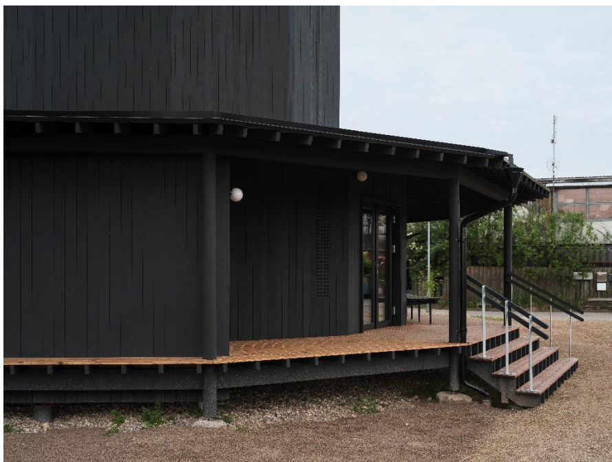
Eksteriør med trappen mod vest og den overdækkede veranda, som er hævet til siddehøjde.
