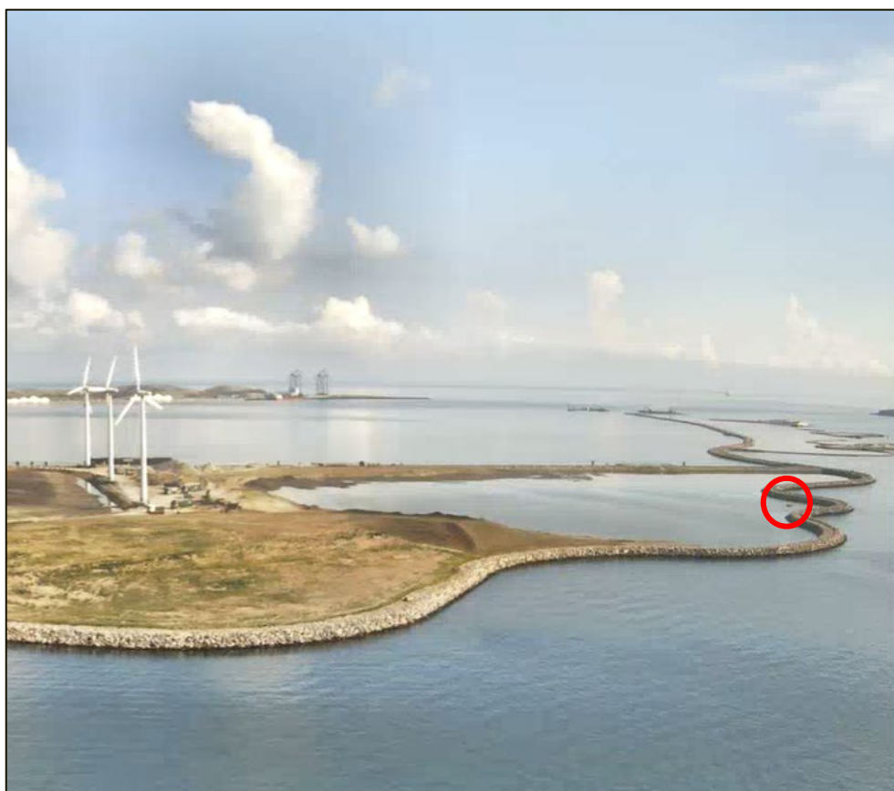
Figur 2-1 Luftfoto af Lynetteholm juli 2025. Fase 1 med bassin A mod højre med åbent vand. Bassin B er opfyldt pr december 2024. DHI's stationer er placeret ved den røde cirkel. Længst til højre det nye kystlandskab.
