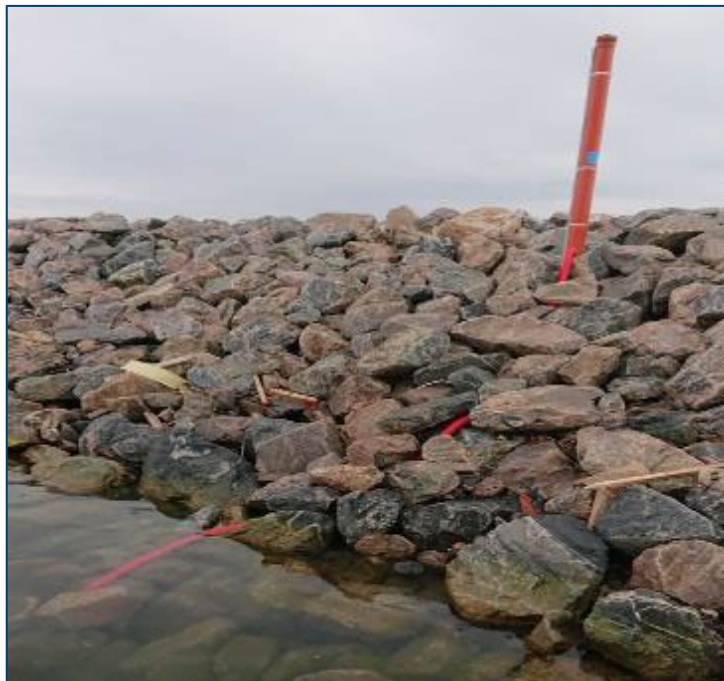
Figur C-1 Vandstandsmåler sat fast i stendæmningen med tryksensor ude i bassinet.
