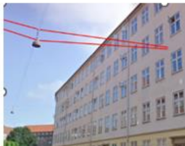
Foto 2: Bæreledninger/wirer vist ved de røde streger fra bygning til gadelampe
