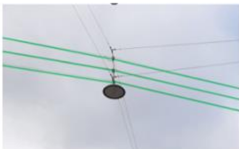
Foto 1: Strømførende luftledninger illustreret ved de 3 grønne linjer
