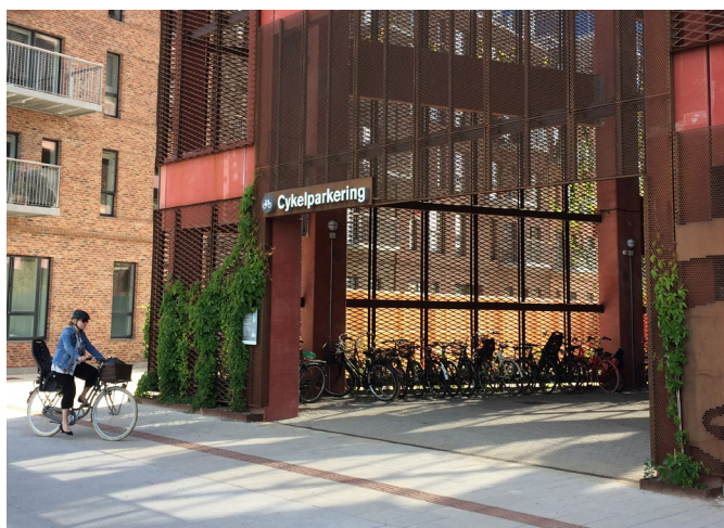
Integreret cykelparkering i P-hus Lüders, Nordhavn
