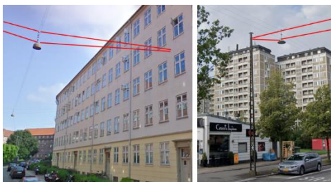
Foto 2: Bæreledninger/wirer vist ved de røde streger såvel fra bygning til gadelampe som fra gittermast til gadelampe.
