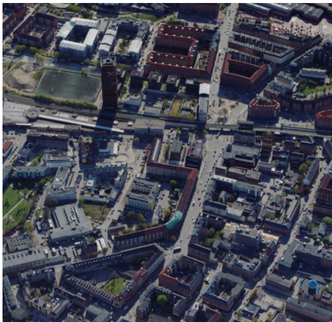
Knudepunkt ved Nørrebro Station, hvor Frederikssundsvej møder Nørrebrogade ved højbanens viadukt.
