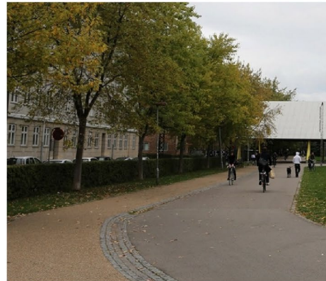
Asfalt cykelsti med OB gangsti
