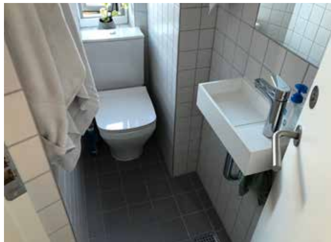
Skanderborggade 4-6 efter renovering.
