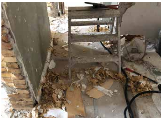
Lejlighed bliver renoveret.
