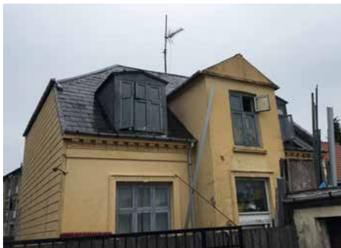
Skjulhøj Allé 12 fra gårdsiden.
