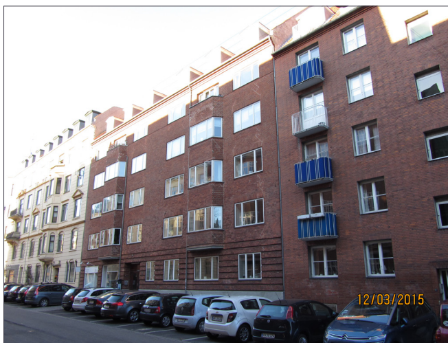
Ejendommen set fra Petersborgvej.
