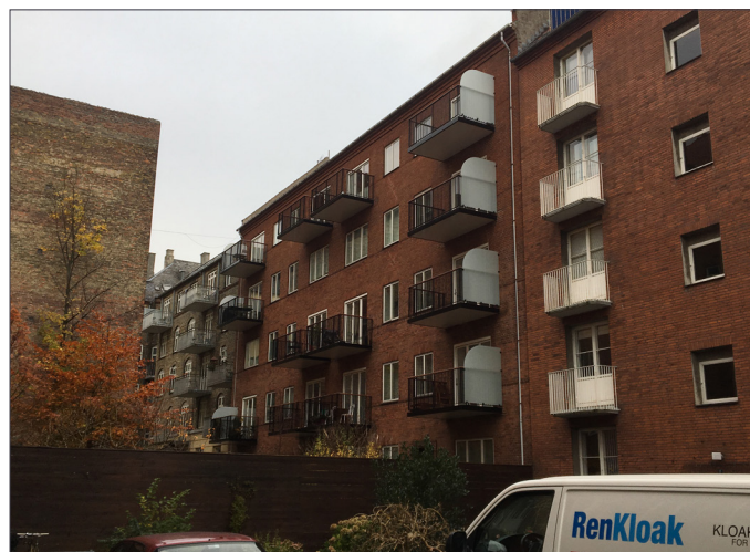
Baghuset med den kondemnerede bolig.
