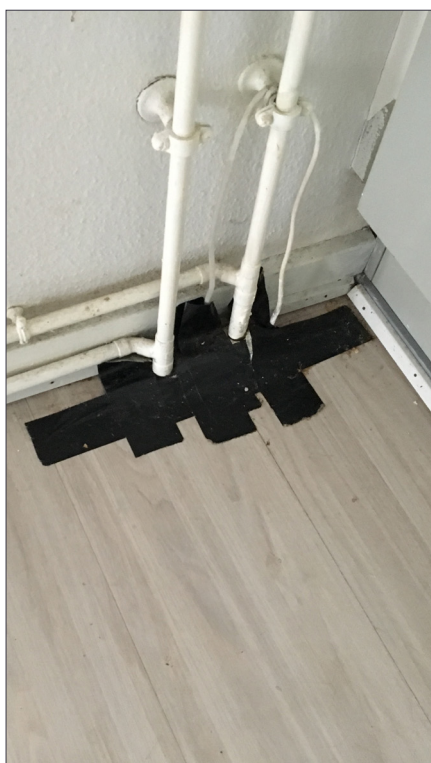
Rørgennemføring i gulv tætnet med tape.
