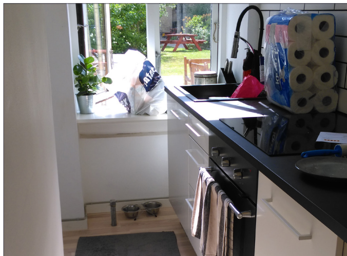
Bolig efter skimmelsanering og opsætning af nye køkkener.
