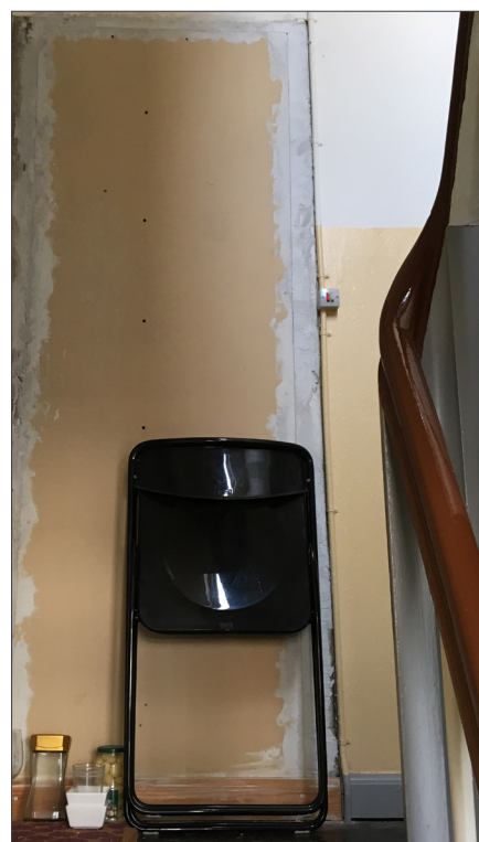
Bitrappe ved 2. sal hvor toilettet er vendt ind i boligen.
