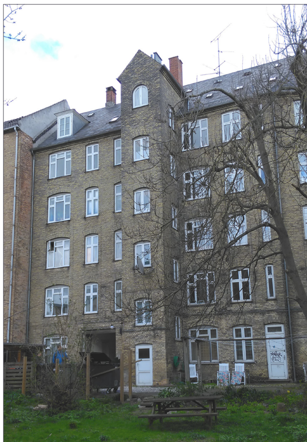
De udeliggende wc-rum er placeret i det uisolerede bi-trappetårn.
