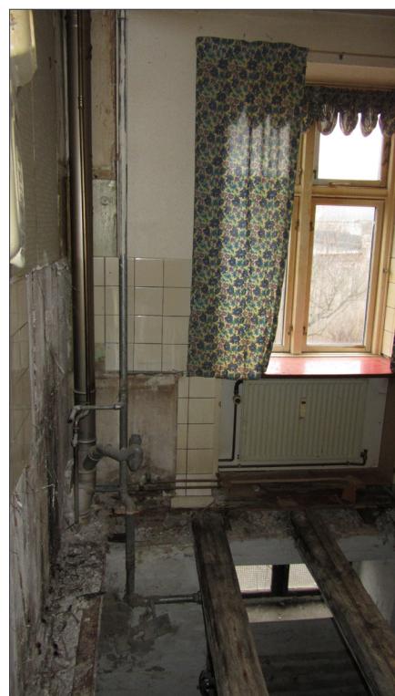
I stueetagen var køkkengulvet fjernet, så kun etagebjælkerne stod tilbage.
