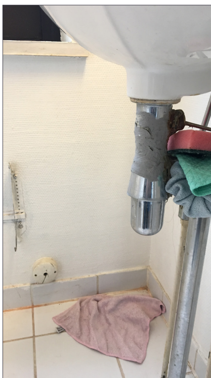
Rep. af afløb i wc/bad samt el-udtag.
