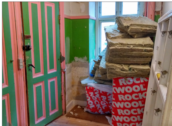
Ejendommen under renovering.
