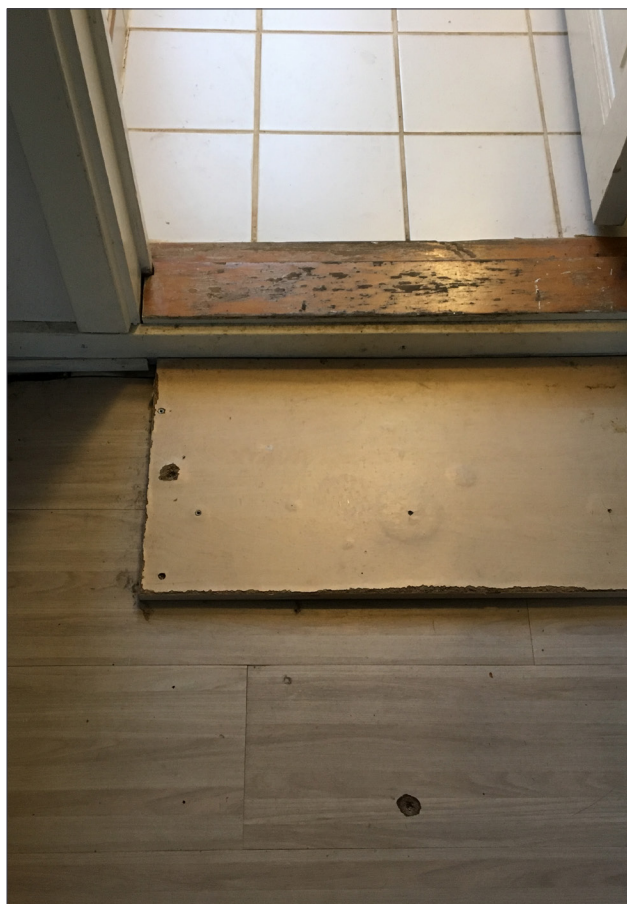
Indgang til toilet i stuen er dækket med plade i gulv.
