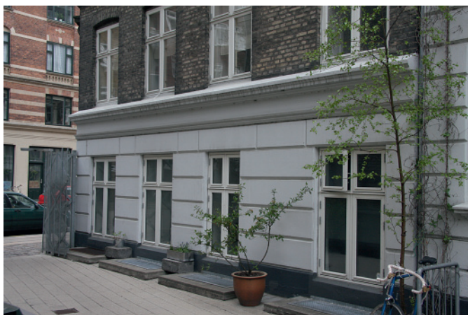
Ryesgade 92-98, øverste kælder
