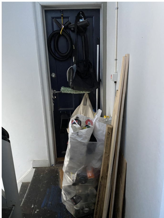
Opbevaring af bohøve på flugtveje udgør et brandfarligt forhold.
