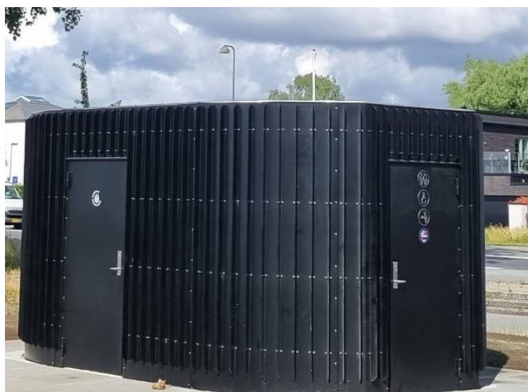
Standardtoilet på Amager Strandvej
