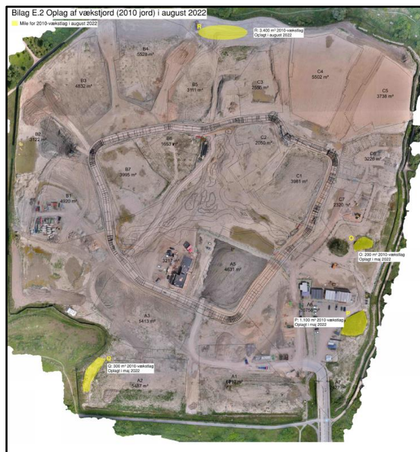
Luftfoto viser oplag af vækstjord (2010 jord) i august 2022.
