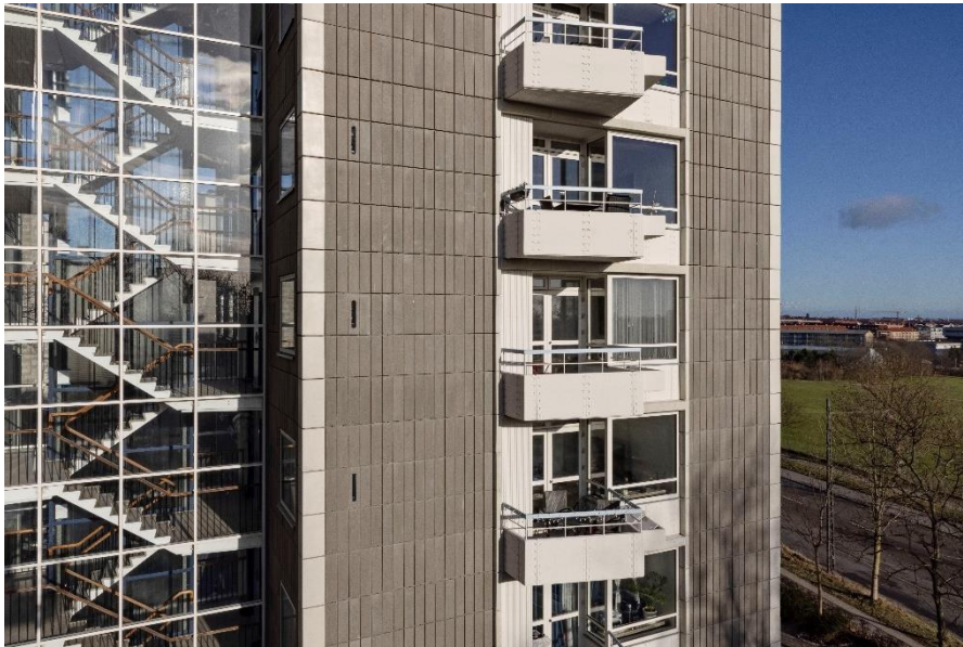
Glastrappe og betonfacade og udsigt mod København.
