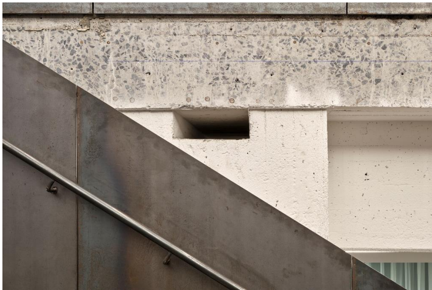
Ny hovedtrappe til Kedelhal.
