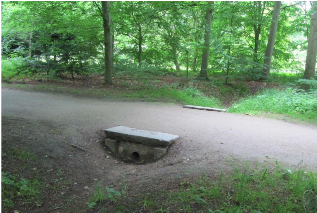
Figur 3 Eksempel på stikrydsning af tør grøft fra Frederiksberg Have
