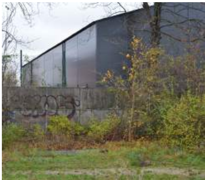
Tennishal ved områdets nordlige afgrænsning
