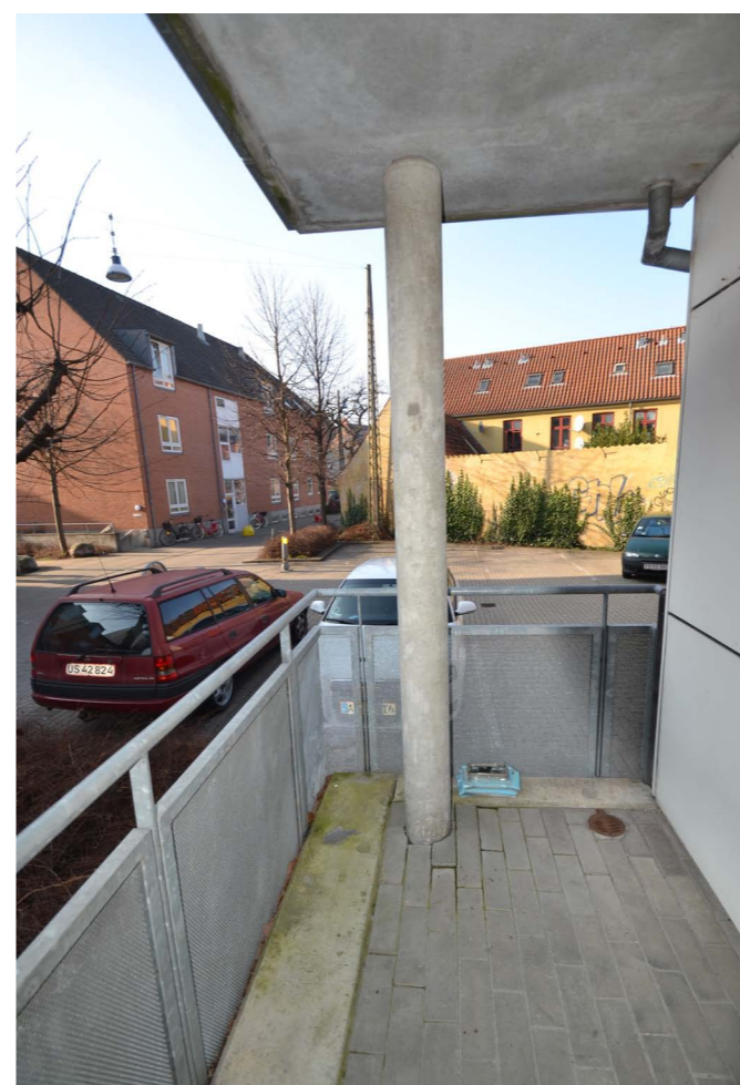
Altanrækværk af stål, betonsøjle og hvid facadebeklædning
