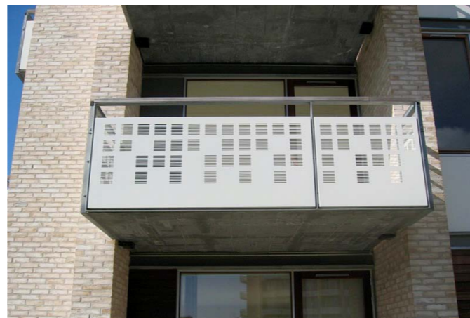
Referent: Perforeret stålplade ved altanværn. Perforeringen kan varieres, så pladen kan blive mere eller mindre gennemsigtig.
