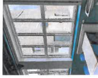
Udsigt til keddebygningen gennem vinduerne i garagebygningen
