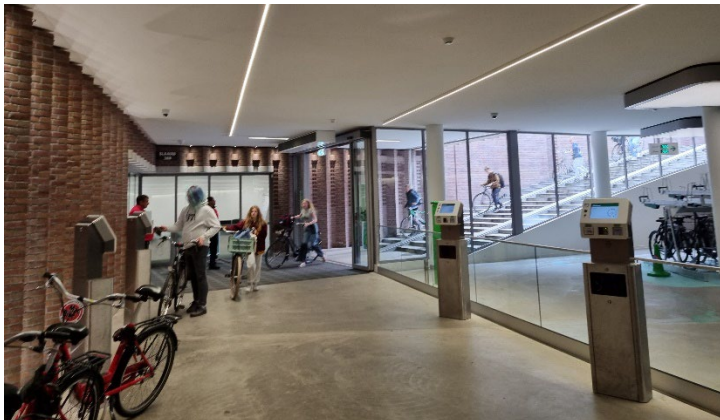
Trappenedgang med sliske og betalingsautomater til cykelparkering under jorden, Leidseplein
