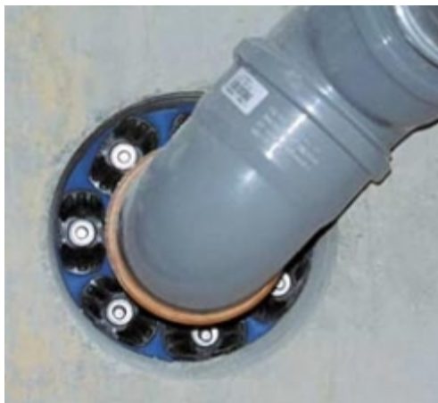
Figur 18 Linksealprodukt til tætning af rørgennemføring i udsparing.
