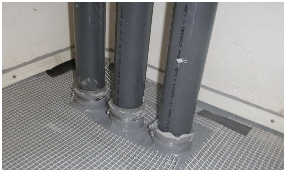
Figur 19 Eksempel på påsvejsning/limning af RAC-membrankrave omkring rørgennemføringer.
