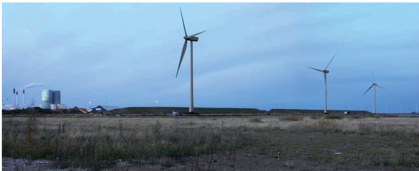
Visualisering af de tre vindmøller placeret på Prøvestenen set fra Copenhagen Marina.
