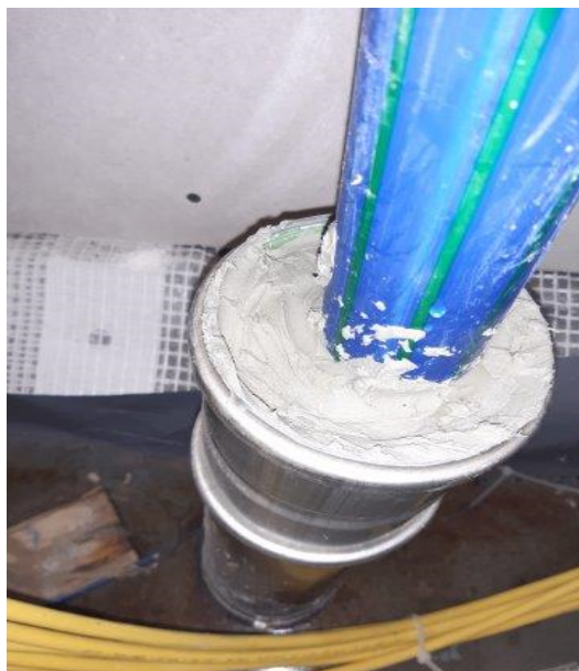
Figur 20 Fugning omkring ledninger i føringsrør.
