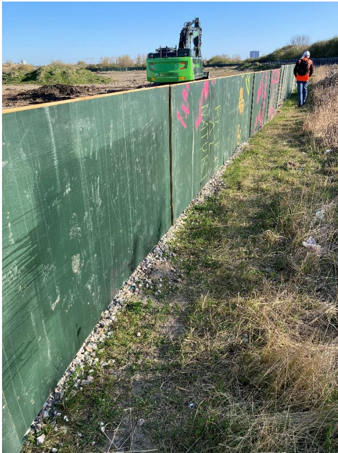
Figur 4 Nyt fast paddehegn ud for det lysåbne areal. Hegnet er forsynet med tætsluttende paddegen i bunden
