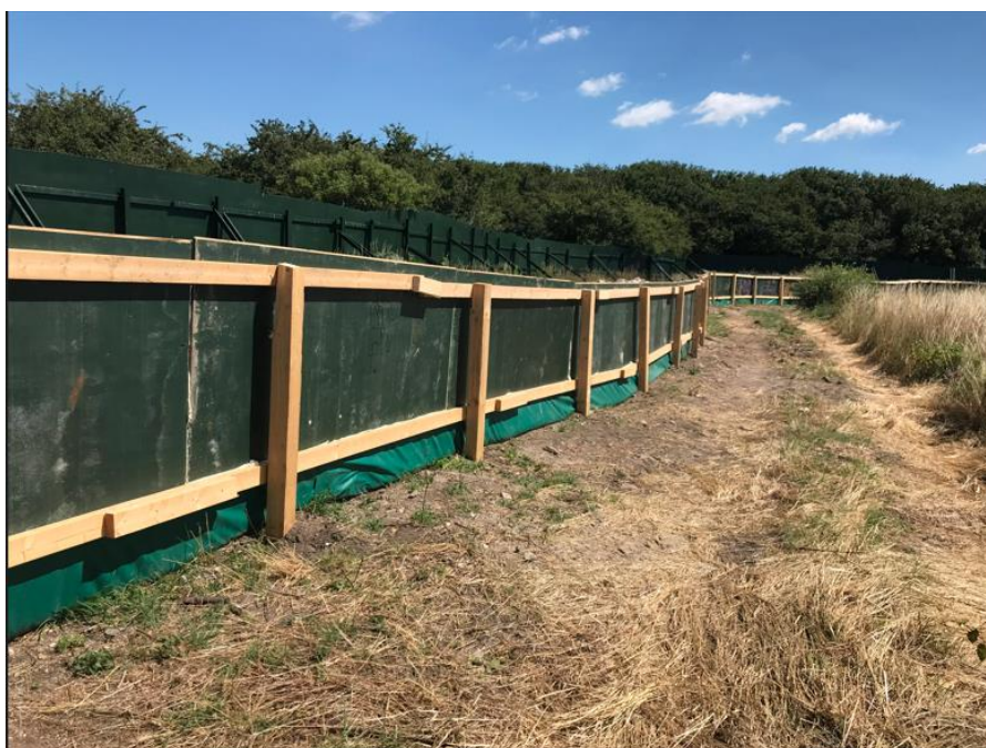
Figur 4 Paddehegn mellem stendiget og byggepladsen, nu indbygget i et pladehegn.
