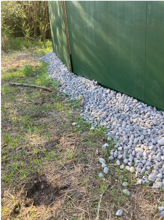
Figur 3: Metrohegn med paddehegn monteret nederst og opfyldt med ral på ydersiden. Foto taget fra ydersiden.
