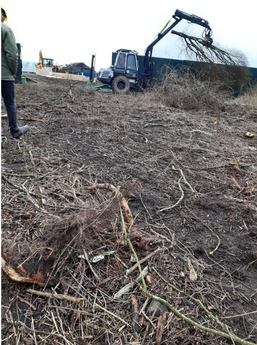
Figur 1 Nederst i venstre hjørne kan ses to rødder, der er blevet trukket op i forbindelse med at fældede grene og stammer er blevet trukket ud af området.
