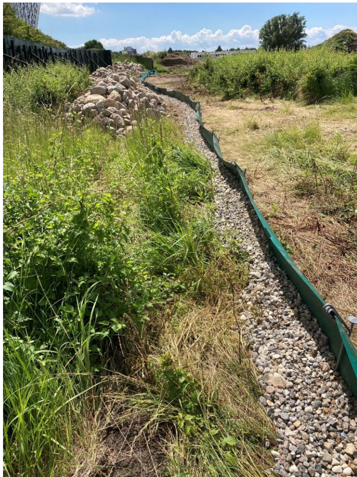
Figur 1 det opsatte paddehegn på vestsiden af diget
