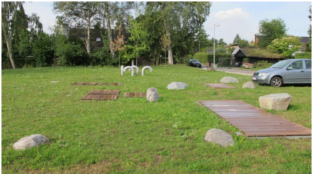
Figur 3 Eksempel på dæksler med plastictræ, og svanehalse til udluftning i baggrunden.
