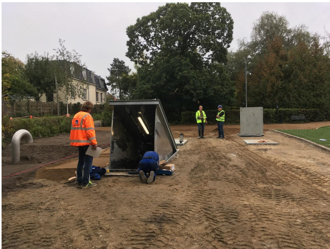
Figur 5 Eksempel på nedgang til bassin, som er konstrueret som et dæksel, som åbnes til en trappe.
