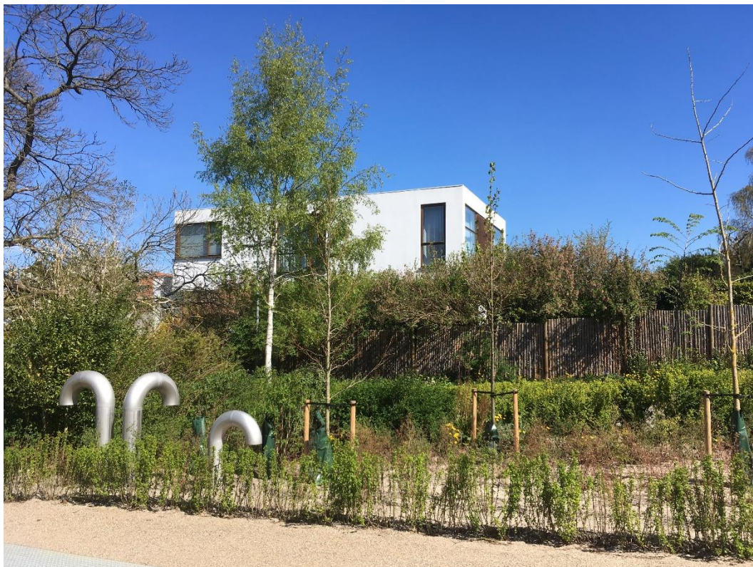
Figur 4 Eksempel på svanehalse til udluftning skjult med beplantning.
