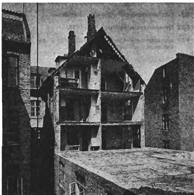
Gårdsanering i Herluf Trolles Gade
