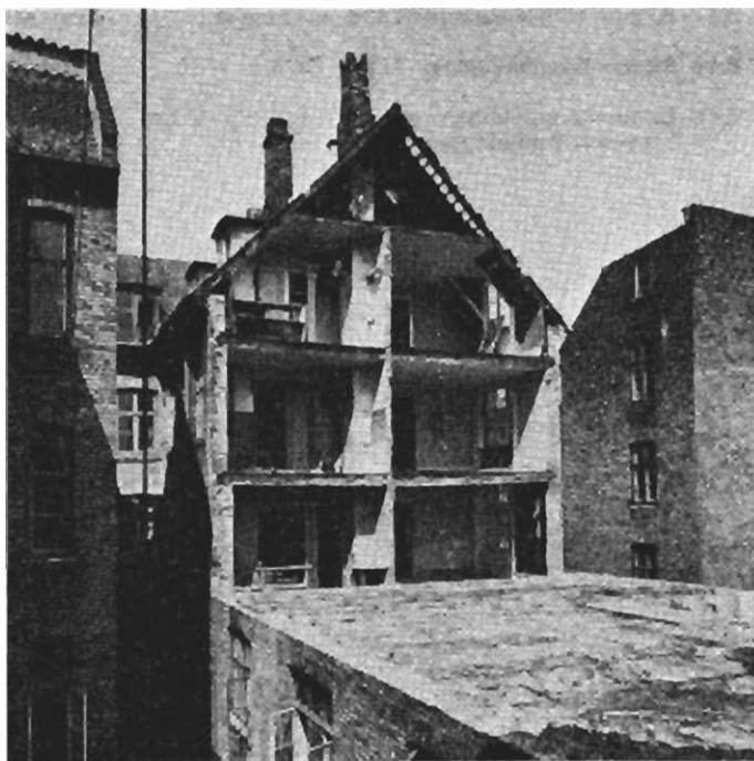
Gårdsanering i Herluf Trolles Gade
